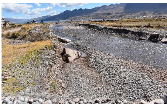
FOTO 01: Se Aprecia el cauce del río Keroruma con flujo de agua permanente sin defensa ribereña Y SE APRECIA DIQUES los cuales están afectados por erosión aguas abajo y aguas arriba.
