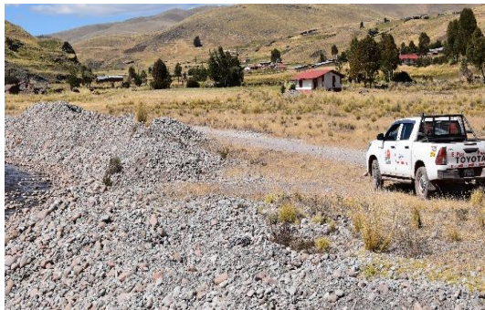
FOTO 03: Se Aprecia el cauce del río Keroruma y por la margen izquierda existe un talud conformado de material propio sin compactar el cual no presta garantía de seguridad, propenso a desborde.
